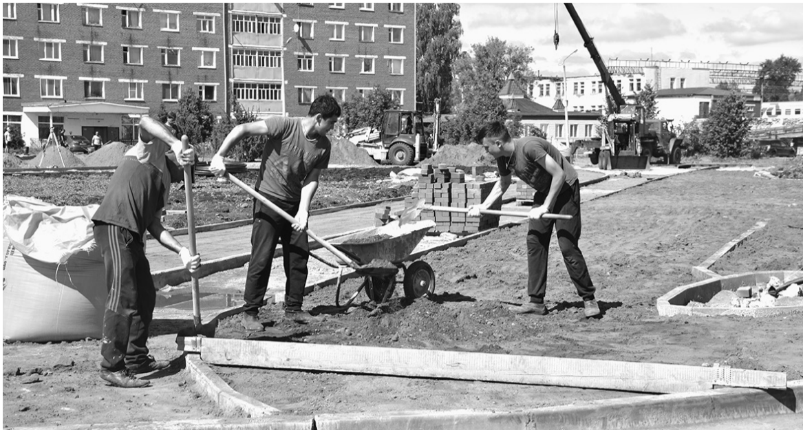
Работники ОАО «МирСтрой» преобразуют привокзальную площадь.
